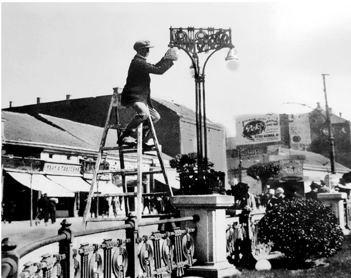
Постављање електричне јавне расвете деведесетих година 19. века на Теразијама
