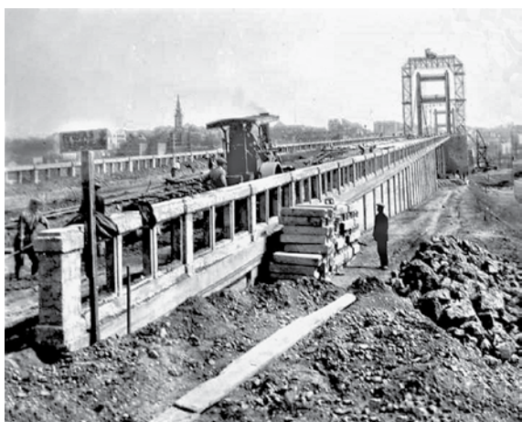
Почетак градње моста на левој обали Саве
