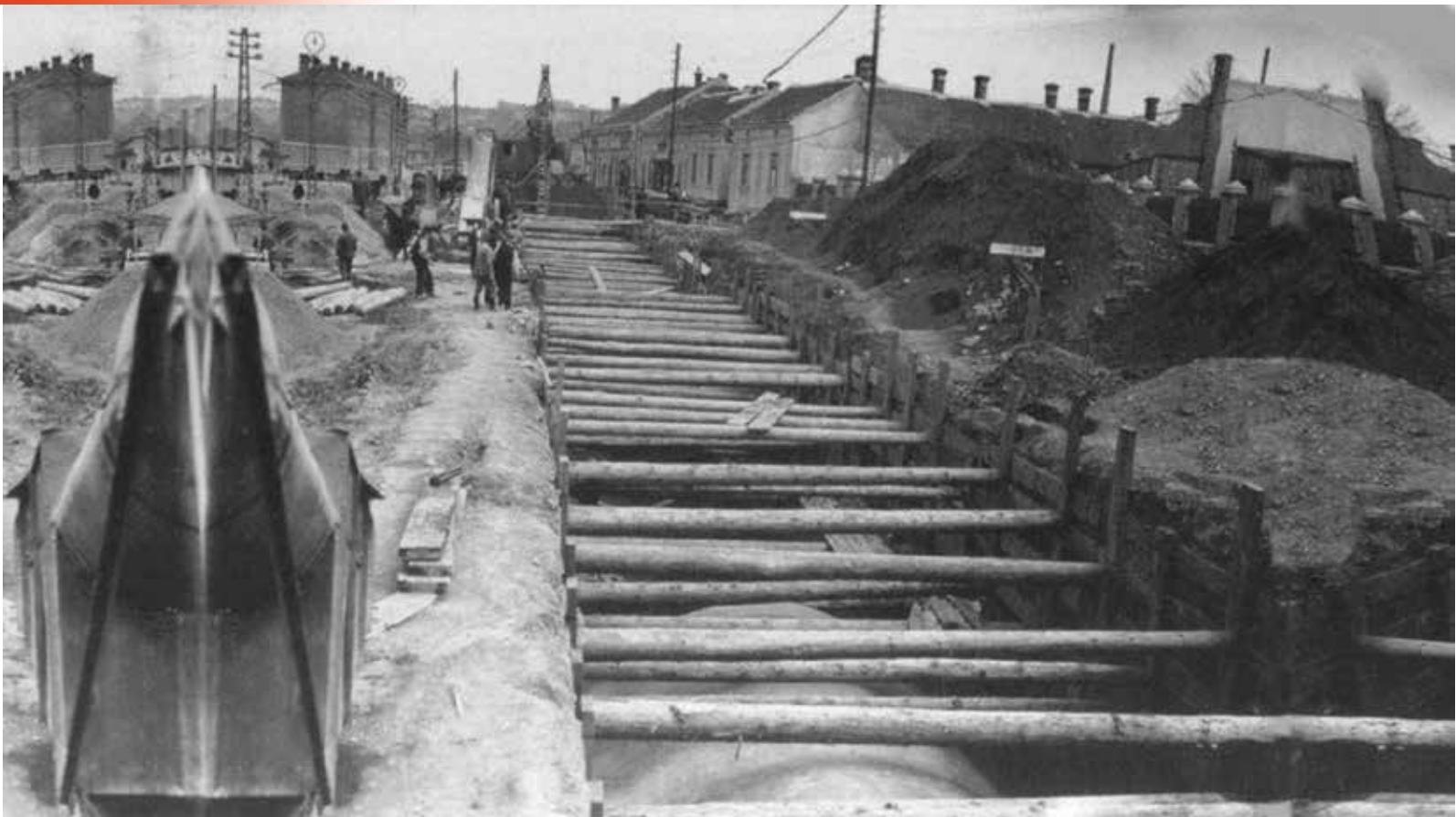
Постављање канализационих цеви у улици Војводе Степе, код „Господарске Механе“
