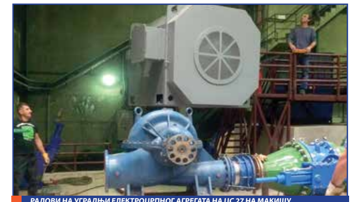
РАДОВИ НА УГРАДЊИ ЕЛЕКТРОЦРПНОГ АГРЕГАТА НА ЦС 27 НА МАКИШУ
