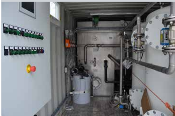
Део мобилног постројења у коме се врши пречишћавање воде
