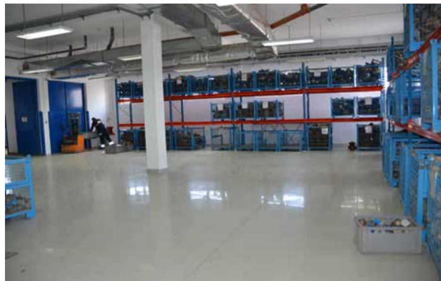
Нови под у Баждарници после радова
