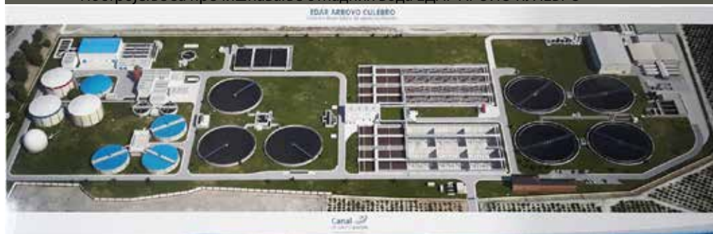
Постројење за пречишћавање отпадних вода ЕДАР АРОИО КУЛЕБРО
