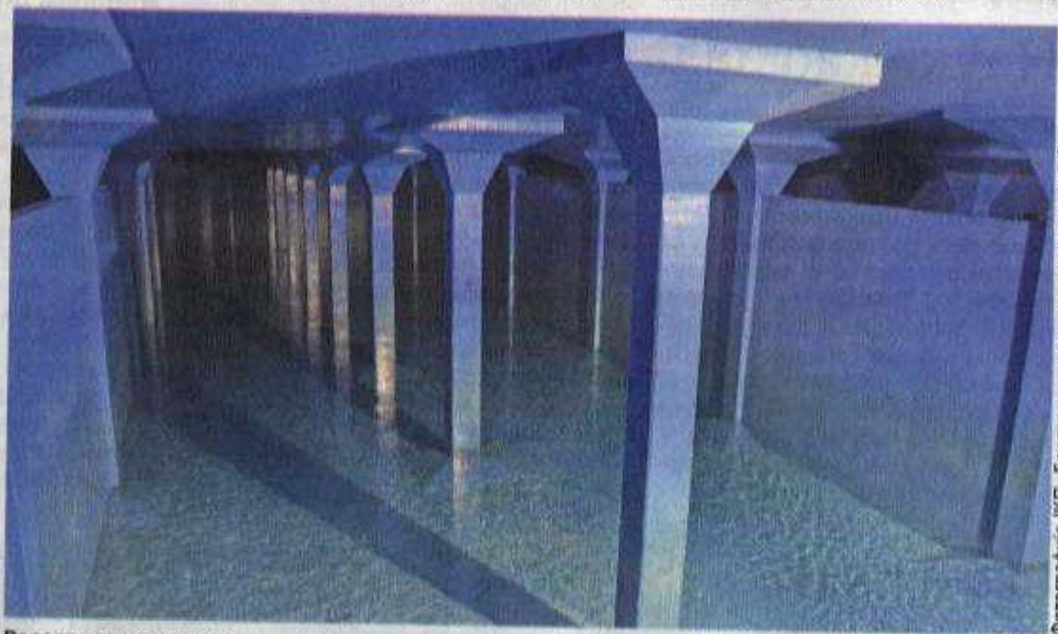
Резервоар чисте воде
