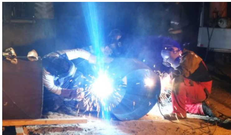
Радови на санацији водовода у Карађорђевој улици
