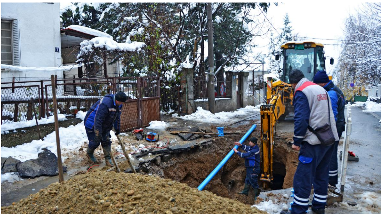
Поправка квара на водоводу у Костолачкој улици
