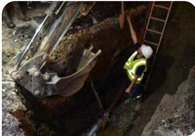
Радник БВК отклања квар на циви
