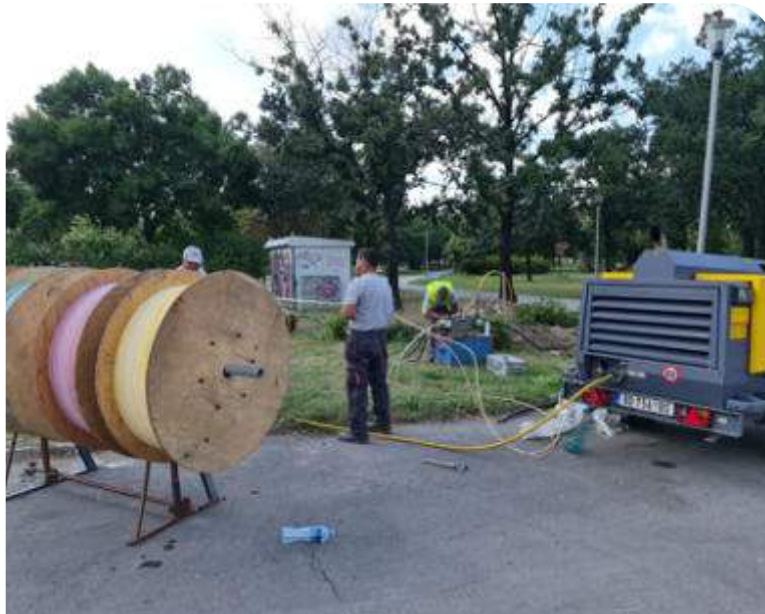
Удувавање микроцеви кроз цев у Колектору
