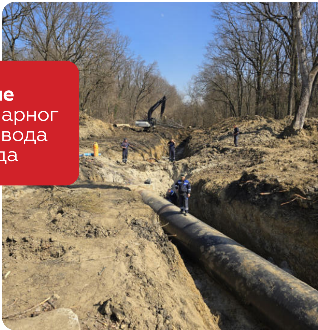
Екипе водовода раде на цевоводу ПП Макиш
