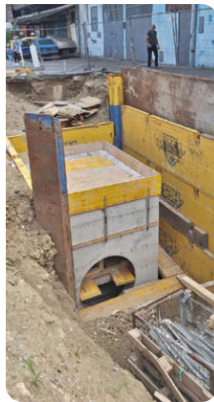
Каскадна грађевина где долази нови колектор фи 1500 одакле је повезан на НМК. То је добока грађевина од 9 м
