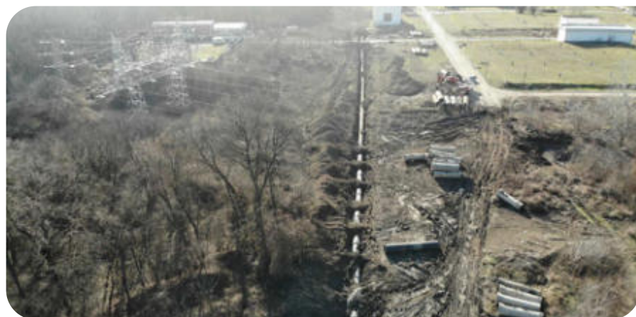
Замена дела челичног цевовода на ПП Макиш
