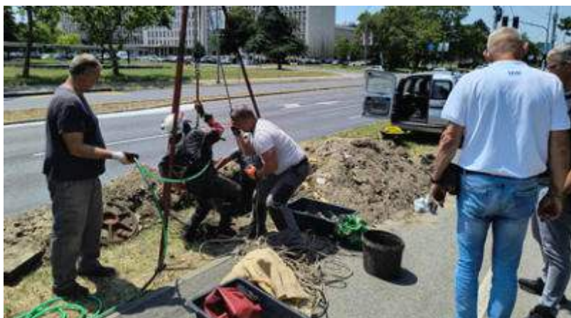
Извлачење радника из канлизационог отвора након завршено провлачења оптике
