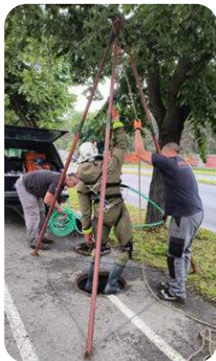
Спуштање радника у канализациони отвор са професионалном опремом
